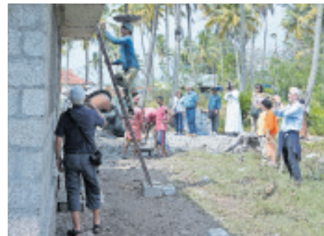
Oben: Der Besuch einer laufenden Baustelle stand ebenfalls auf dem Programm.
